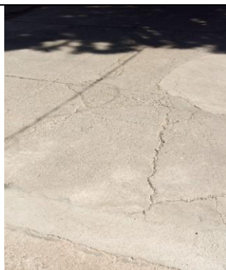
Contrapiso de Hormigón
