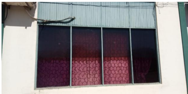
Pintura marcos ventana
