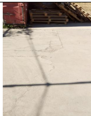
Contrapiso de Hormigón
