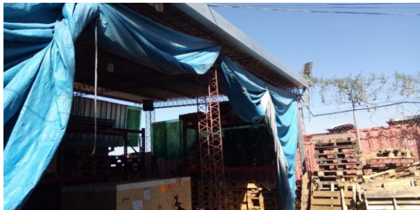
Provision e instalación luminarias led
