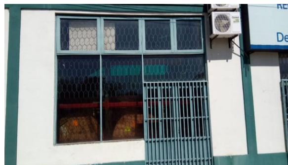
Pintura marcos ventana
